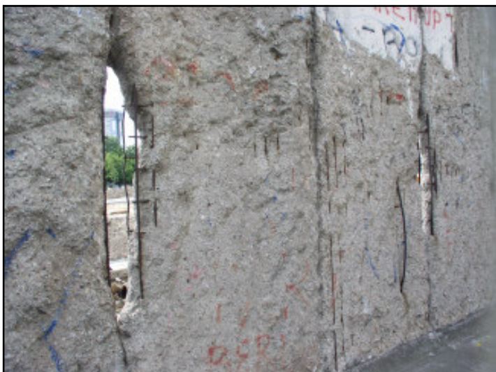
Un pezzo del Muro rimasto
