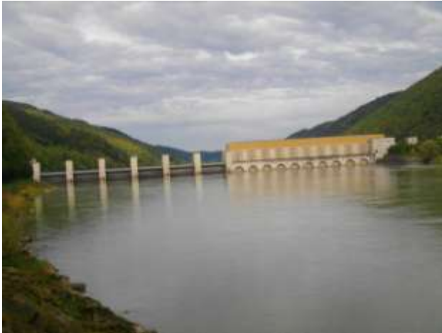
La centrale elettrica
