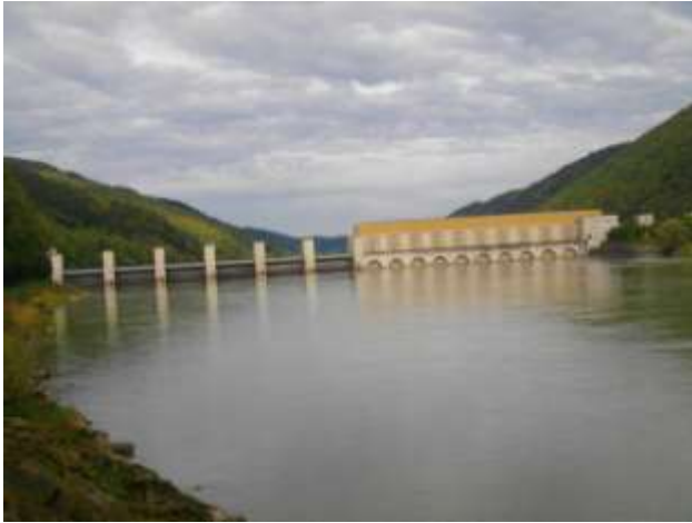
La centrale elettrica
