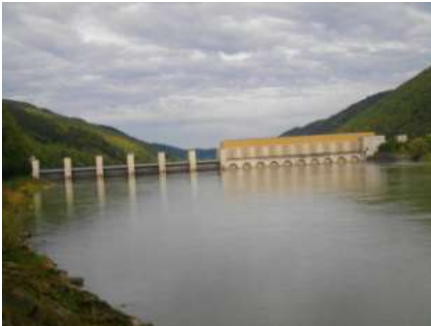
La centrale elettrica
