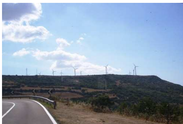
Centrale eolica a Escalaplano
