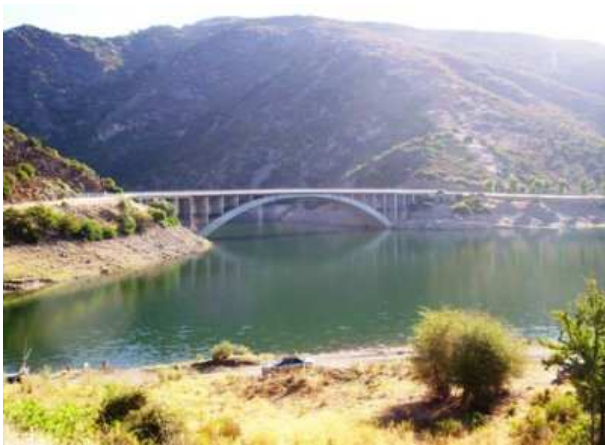
Ponte sul Flumendosa - Villanovatulo
