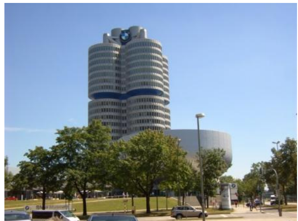
Monaco: le avveniristiche torri della sede della BMW
