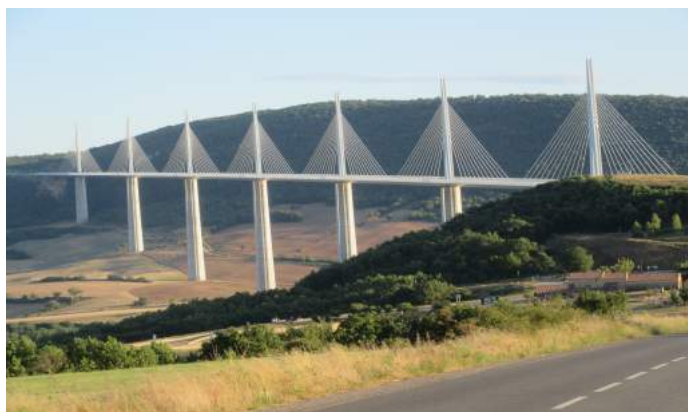
Il viadotto di Millau
