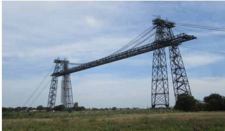
Le Pont Transbordeur
