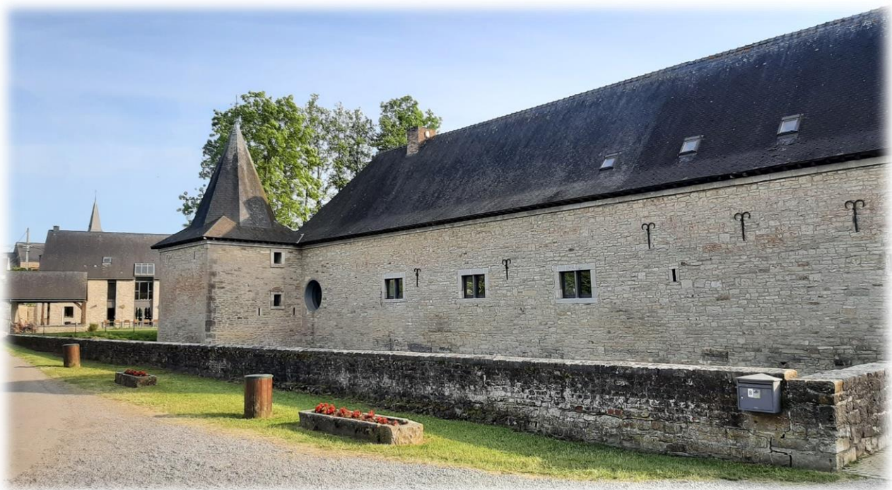
Castello di Lavaux-Sainte-Anne
