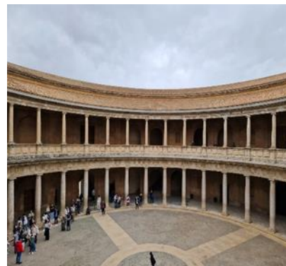
Patio e portico palacio de Carlos V
