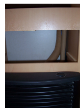
Vista verticale del vano sopra la stufa con la derivazione che passa a fianco del camino
