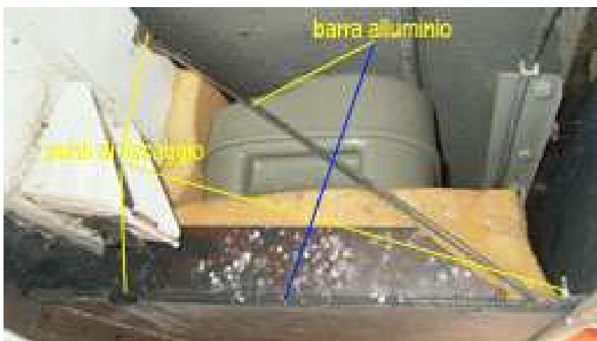
Tagliamo il compensato e sagomiamolo a misura, tra il telaio e la bandella, fissiamolo con le viti, mettiamo l'altro pezzo di compensato che ci farà da sportello
