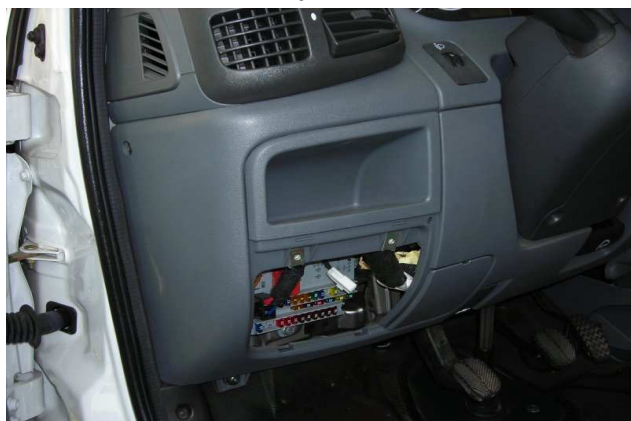
Foto 3: Scatola fusibili aperta
