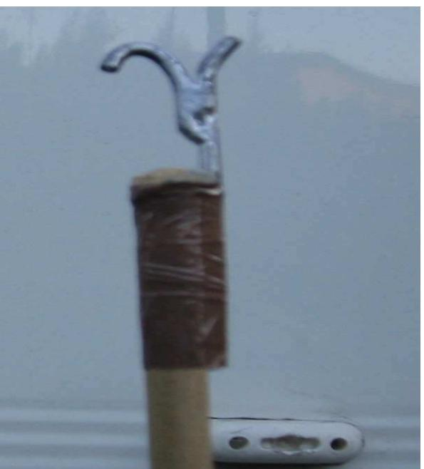
Ultimo dettaglio il sistema di bloccaggio Pannello chiuso (abbassato). Ho utilizzato una serratura (recuperata da un'autodemolizione) di un portellone per Panda (molti altri modelli sono utilizzabili). Le modifiche apportate sono state minime (raddrizzamento e allungamento (tramite saldatura) perno di sblocco), fissato con tre viti su uno squadretto a sua volta fissato direttamente al Pannello.
