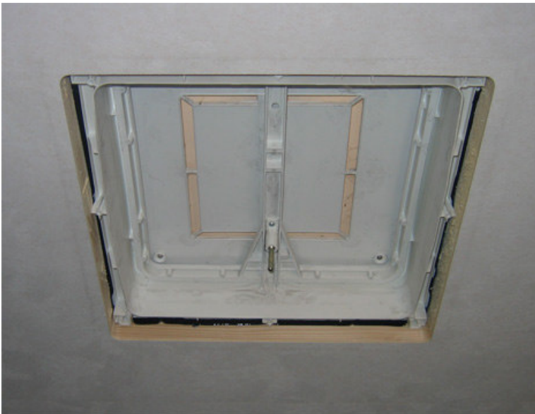
Figura 1 - rimozione del coperchio interno
