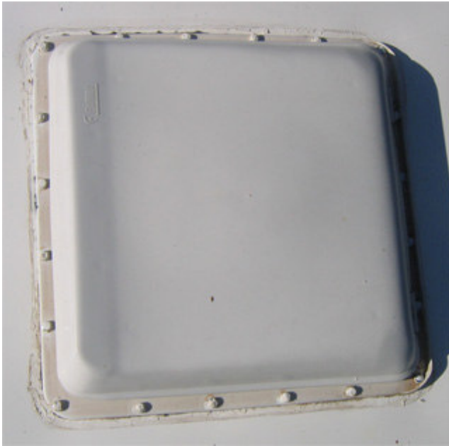
Figura 3 - rimozione del sigillante esterno
