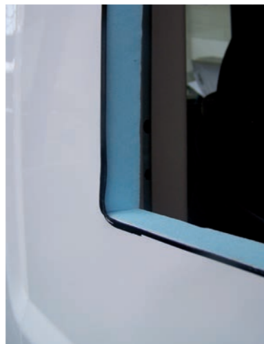
ÉTANCHÉITÉ OUVRANTS MATÉRIAUX IMPUTRESCIBLES
