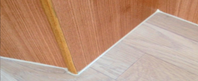
JOINT ÉTANCHÉITÉ AU SOL
