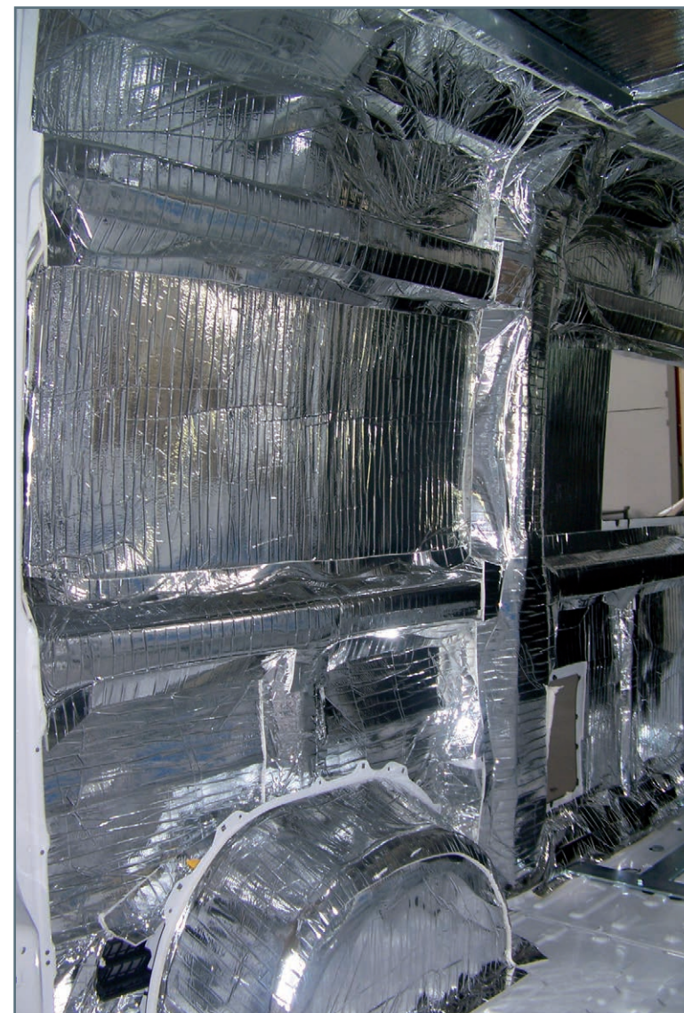
ISOLATION XHP COMPLÈTE PAROIS INTÉRIEURES ET PLAFOND
