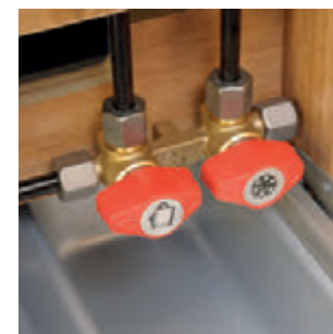
Répartiteur central de gaz Distribución del gas
