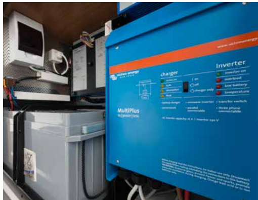
+ victron energy MultiPlus Lade-/Wechselrichter­kombination (optional) (4)
