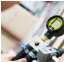
Gasol. Gasolsystemet trycktestas.
