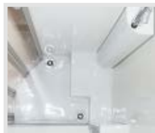
▲ Zona doccia di grandi dimensioni
