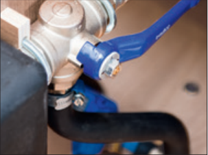
Direktabfluss; als Bypass für den Abwassertank
