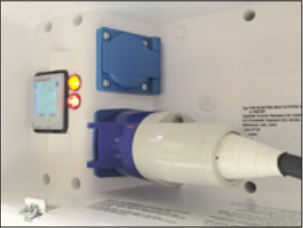
Stromzähler im Schaltkasten
