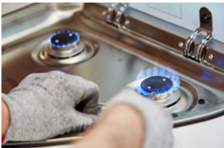
Test sul funzionamento delle condutture del gas.
