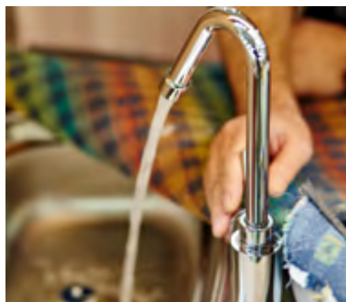
Corretta installazione degli impianti idraulici.
