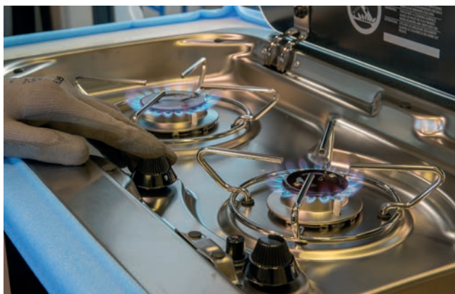
Test sul funzionamento delle condutture del gas.
