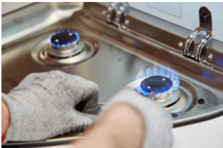
Test sul funzionamento delle condutture del gas.
