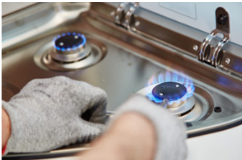
Test sul funzionamento delle condutture del gas.
