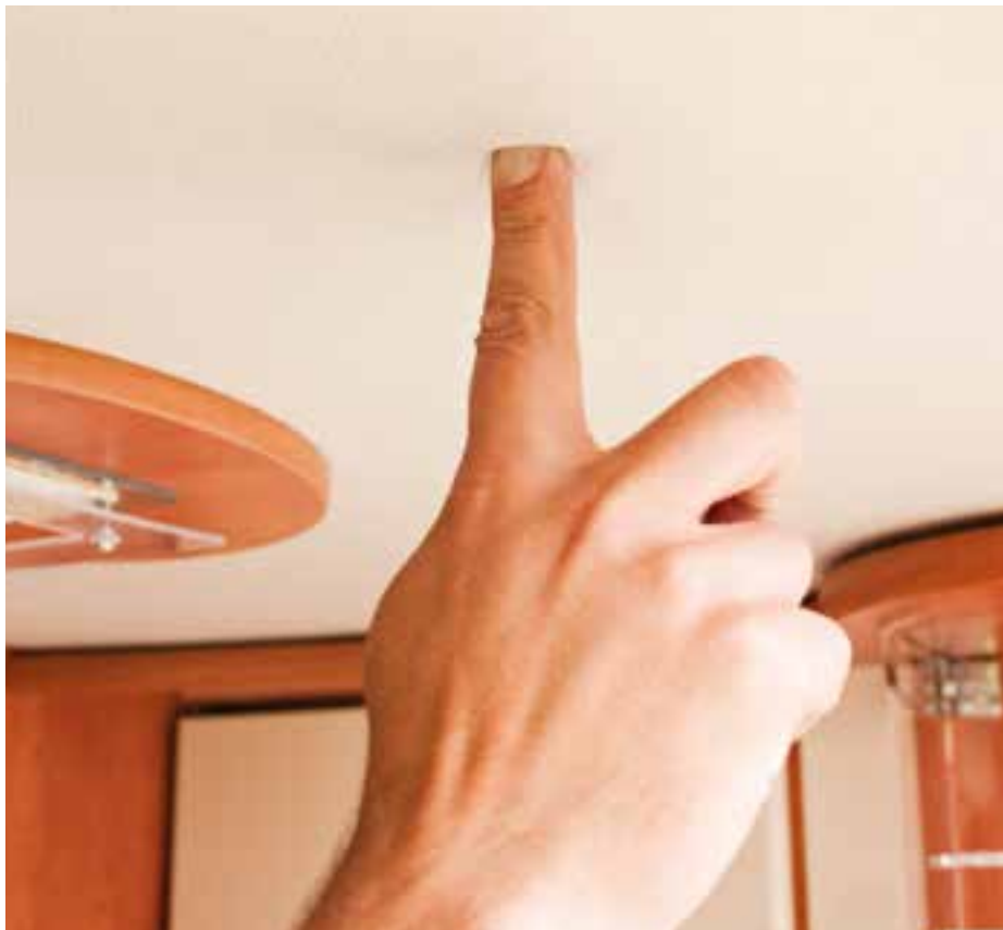
MOUSSE ISOLANTE AU PLAFOND
