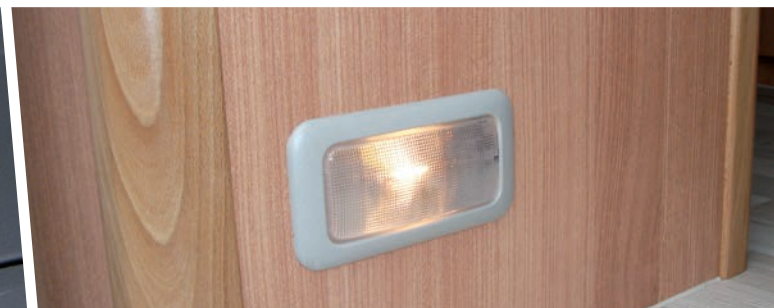
AUTOMATISCHE BELEUCHTUNG ZELLE ALUMBRADO AUTOMÁTICO DE CELDAS / ILLUMINAZIONE AUTOMATICA CELLULA
