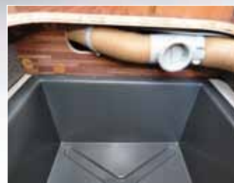
• doppio pavimento riscaldato
