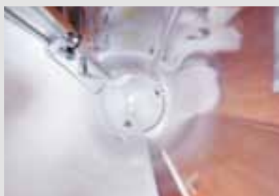
Pozzetti a pavimento nella doccia
