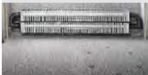
Convettori riscaldanti nel doppio pavimento
