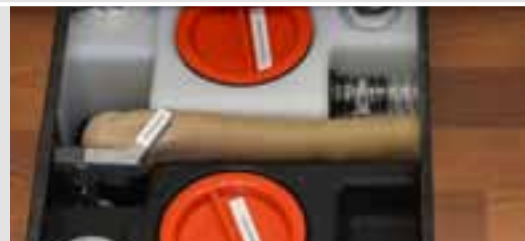
Riscaldamento mirato dei serbatoi
