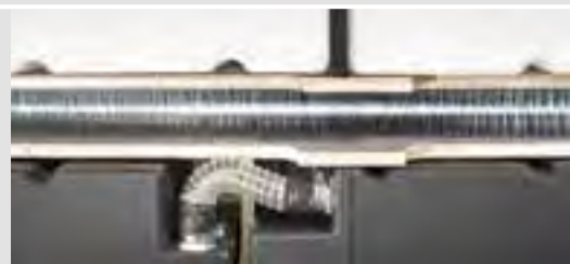
Riscaldamento mirato dei serbatoi
