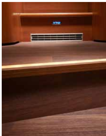
Gradino abitacolo con illuminazione superficiale
