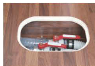
Tankablasshähne frostsicher im beheizten Doppelboden, von Eingangsbereich zugänglich.
