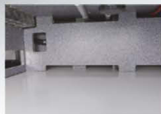
Luftkanäle im Doppelboden „high-line 300“ zur gleichmäßigen Wärmeverteilung.
