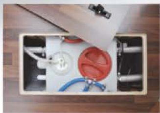
Wassertanks im Doppelboden „high-line 300“.
