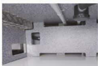
Luftzirkula- tionskanäle im Doppelboden „space“.
