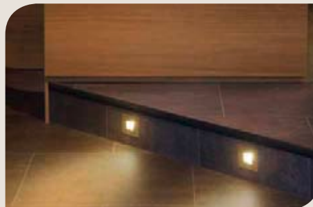
► Beleuchtete Trittstufe sorgt für Sicherheit und ein schönes Lichtambiente
