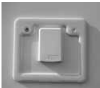
SOG: ventilazione wc automatica
