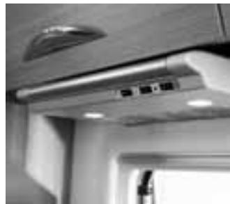
Cappa aspirante: 12 volt, con espulsione diretta attraverso la parete esterna
