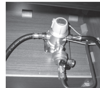
Duo Control inklusive Eis-Ex: automatischer Umschalter von leere auf gefüllte Gasflasche, mit Frostschutz
