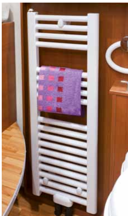
Radiatore scalda asciugamani per riscaldamento ad acqua calda
