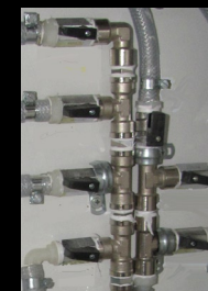
Impianto idrico a collettore sezionabile per ogni singola utenza
