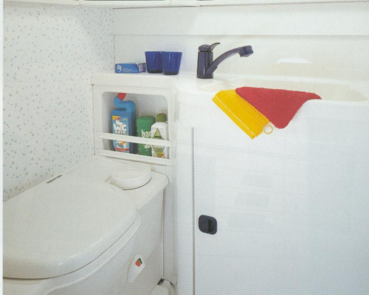
Waschraum mit Frischwasser-Spültoilette.
