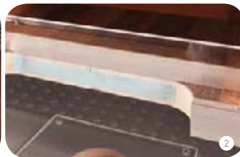
2 Il taglio porta alla luce del giorno: il materiale isolante XPS del doppio pavimento multifunzionale per un ottimale isolamento tutt'intorno.
