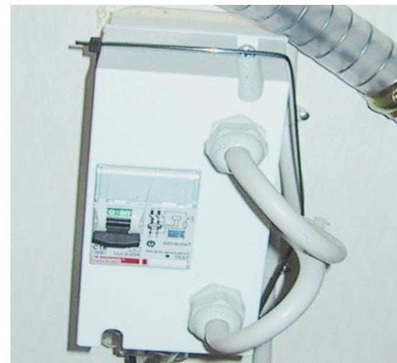
FOTO 15 INTERRUTTORE TERMOMAGNETICO
