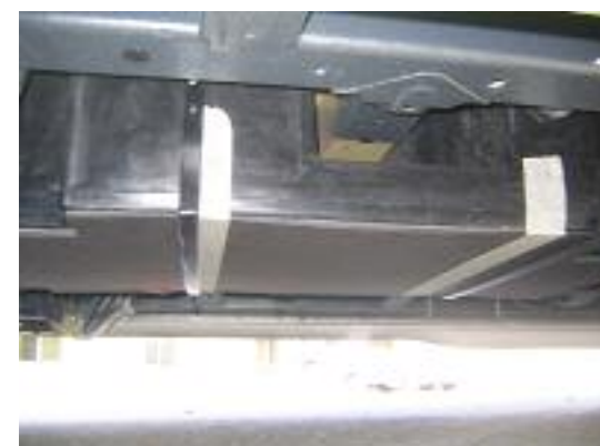
SERBATOIO ACQUE SCURE
