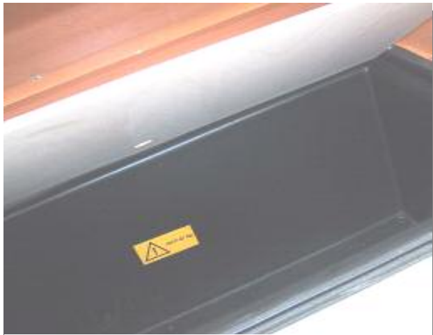
FOTO 41: GAVONE INTEGRATO PAVIMENTO
