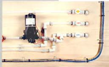
Alle Kabel, Ver- und Entsorgungsleitungen sind entsprechend ihrer Funktion gekennzeichnet.
