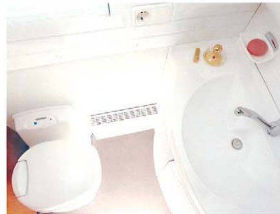
Der Waschräum mit Cassettentoilette
