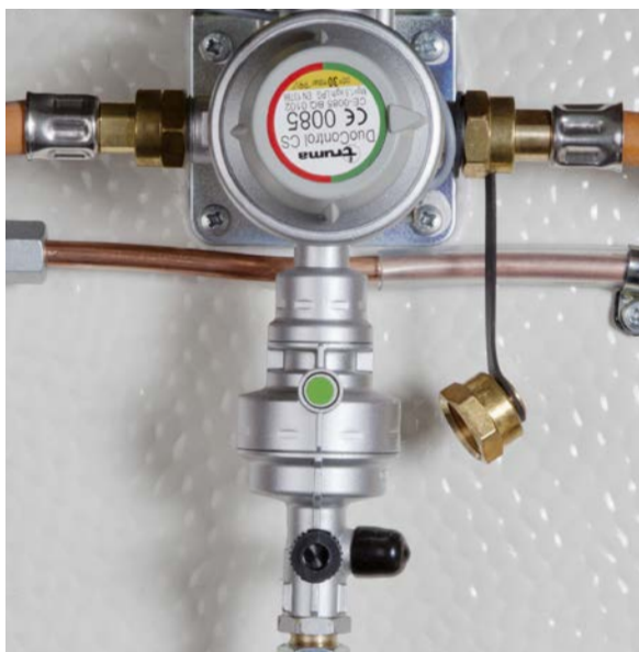
Gasolomkopplare Med en gasolomkopplare kopplar gasolflaskan automatiskt om till reservflaskan när den ena tar slut.
