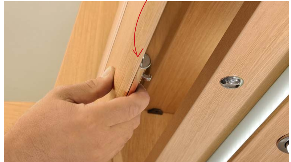
Neues, verdecktes Verschluss-System mit Metallriegeln.
