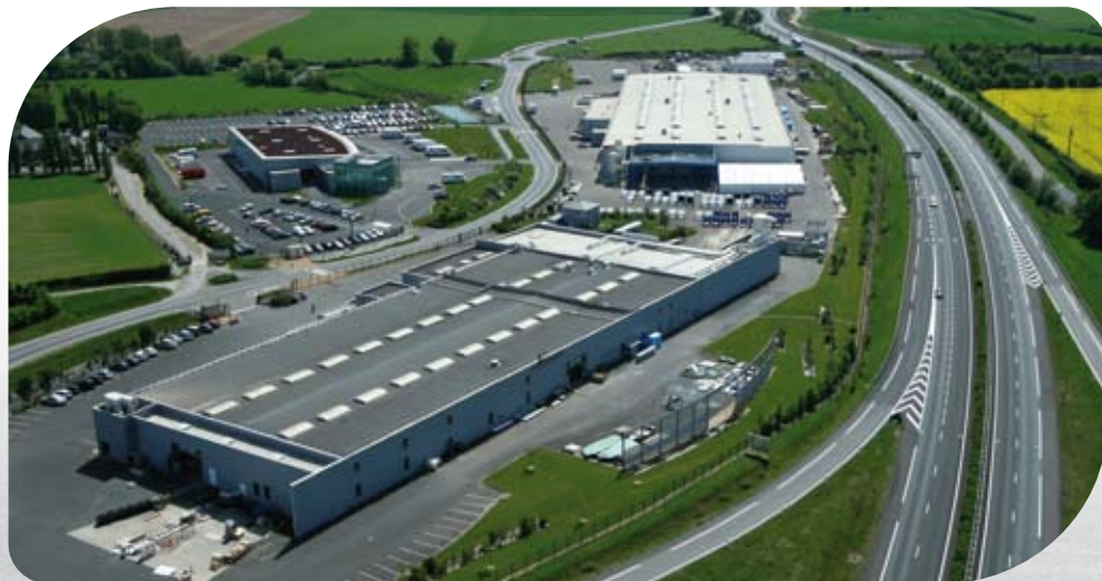
Production plant BAVARIA of La Membrolle sur L'ougnée, site of manufacture of the FJORD on basis FIAT and MERCEDES models / Die Fabrik PILOTE in La Membrolle sur L'ougnée: Produktionsstätte der Modelle FJORD auf FIAT und MERCEDES. / Stabilimento BAVARIA a La Membrolle sur L'ougnée, dove vengono prodotti i modelli Fjord su FIAT e MERCEDES.
