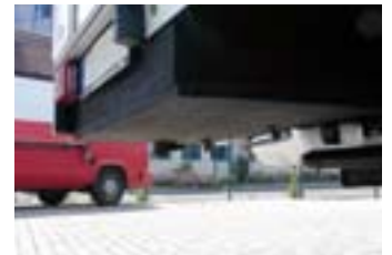
Abwassertank, isoliert und beheizt
