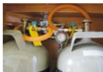
Gasregler-Anlage Truma DuoComfort
