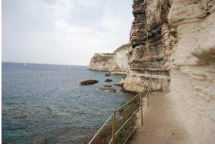
Camminamento delle "Escalier du Roi d'Aragon"
