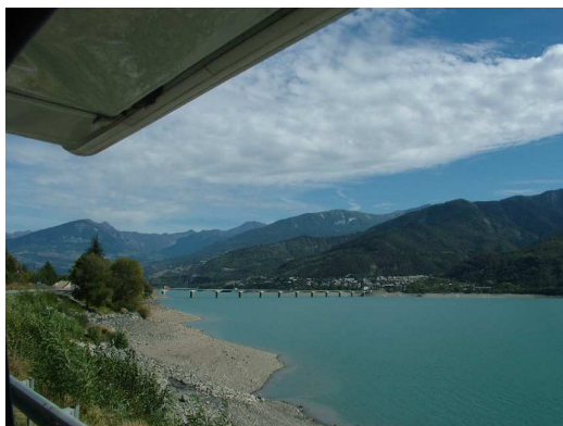
Ponte sul lago di Serre Ponçon
