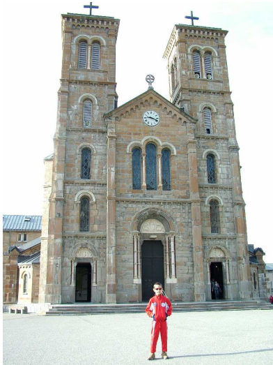
Facciata del Santuario
